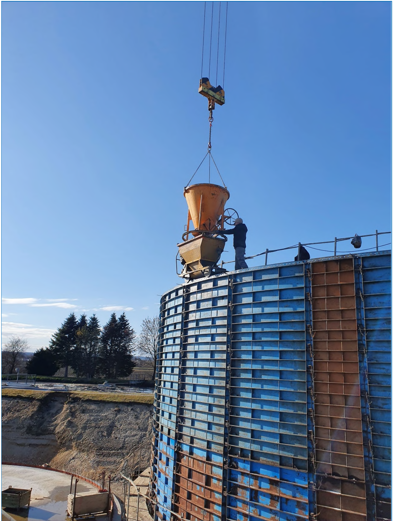
Abb. 3: Schließlich wird der Beton eingefüllt, Runde für Runde muss der Spezialwagen oben fahren. Foto: Eger GmbH
