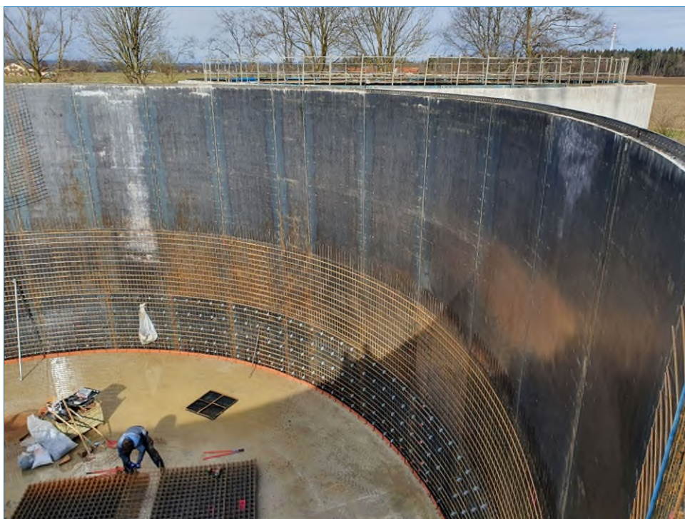
Abb. 2: Im Inneren eines Behälters: Die Außenschalung steht schon, jetzt werden die Stahlmatten eingeflochten. Foto: Eger GmbH
