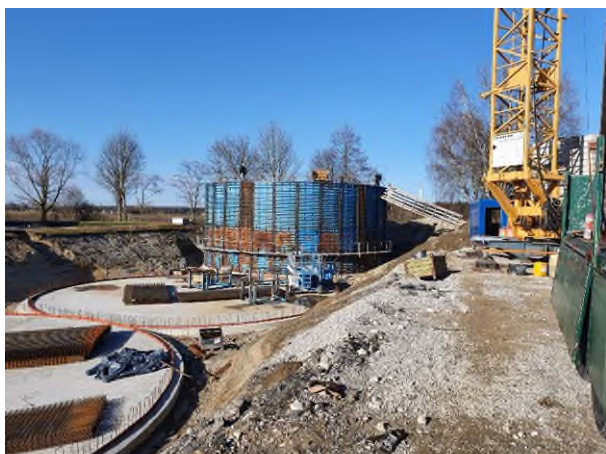
Abb. 1: Im Bau sind derzeit die beiden offenen Behälter der Belebungsanlage sowie der geschlossene Behälter zur Nachklärung. Foto: Eger GmbH
